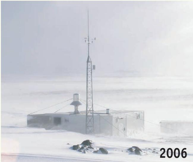
Station radionucléides aérosols sur les îles Kerguelen. Sur le toit, le préleveur aspire l'air ambiant afin de détecter les isotopes radioactifs marqueurs d'un éventuel essai nucléaire.
